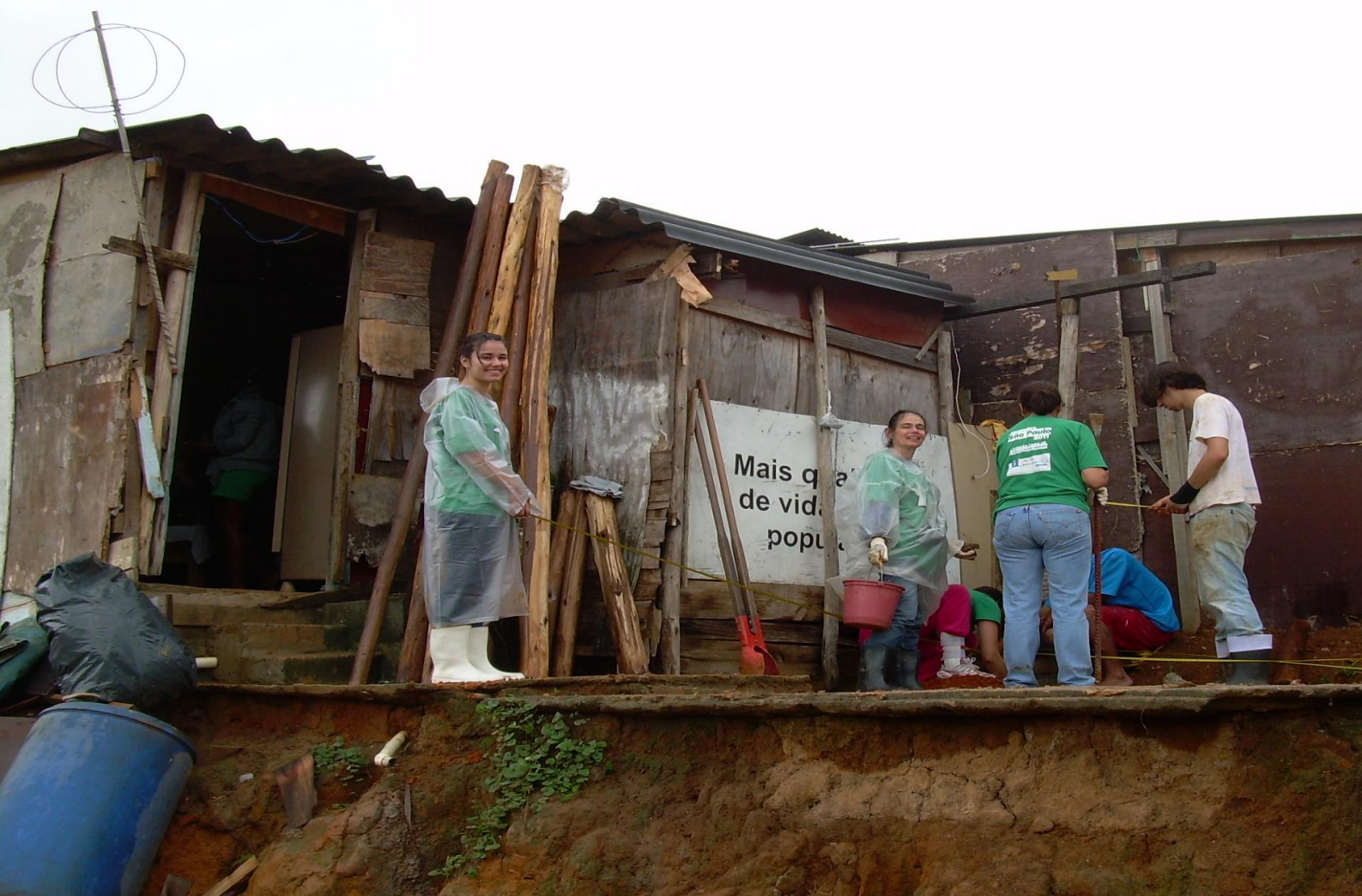
Construção em mutirão OnG Teto imagem cedida arqta. Mirtes Luciani
